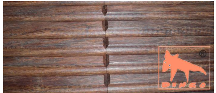
joints sans espacement – avec biseaux
